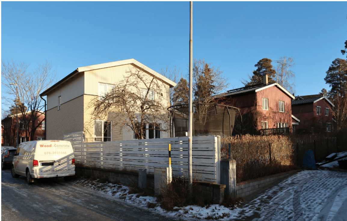
Figur 9: Färgsättningen på det ljusgulbeige huset kan med fördel återställas till den ursprungliga färgsättningen nästa gång huset målats om. Vy mot nordöst från Tallkottsvägen. Foto: Nacka kommun.
