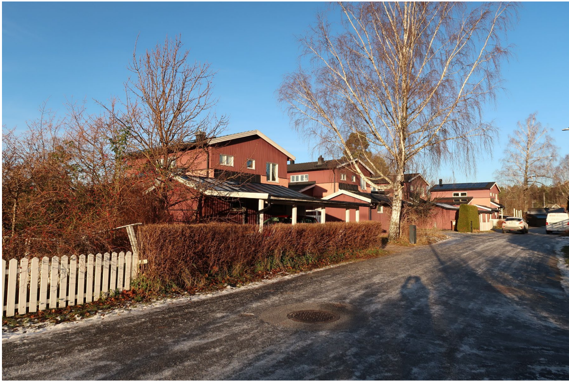
Figur 10: Vy från Tallkottsvägen. De ursprungliga komplementbyggnaderna som placerats närmast gatan samspelar med huvudbyggnaderna i sin gestaltning. Foto: Nacka kommun.
